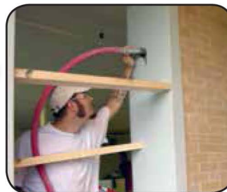
Door frame grouting 門框灌漿
