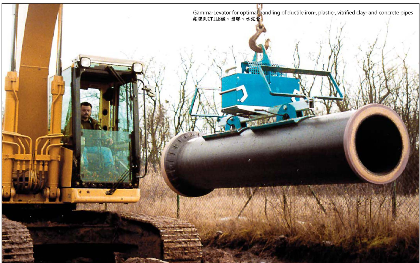
Gamma-Levator with vertical carrying module 使用垂直攜帶模組
